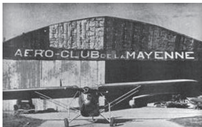
Hangar construit par les allemands
