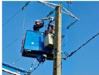
Les techniciens procèdent en bout de ligne au changement des parafoudres amiantés.
