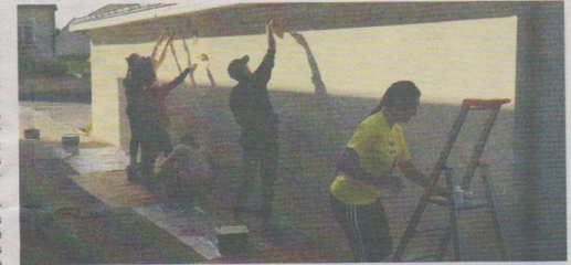
Pendant le dernier chantier Argent de poche de l'été, les jeunes ont repeint le mur du pignon de la salle des fêtes coté maison de santé.
