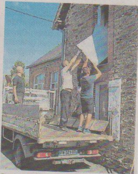
Pendant les vacances, des travaux et aménagements ont été entrepris à l'école Saint-Joseph. (PHOTO : OUEST-FRANCE)
