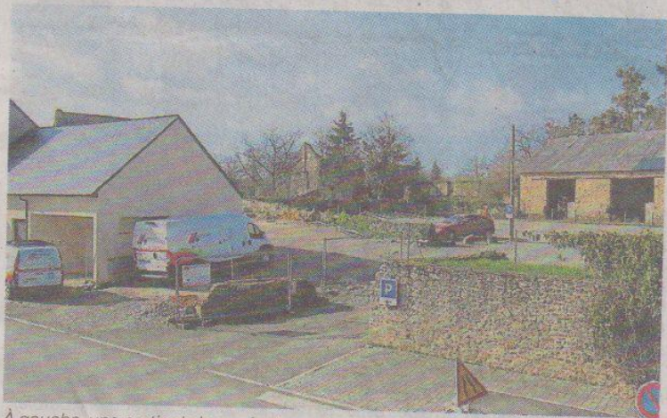
À gauche, une partie de la supérette en fin de construction et derrière le mur ancien, l'emplacement du futur stationnement.
