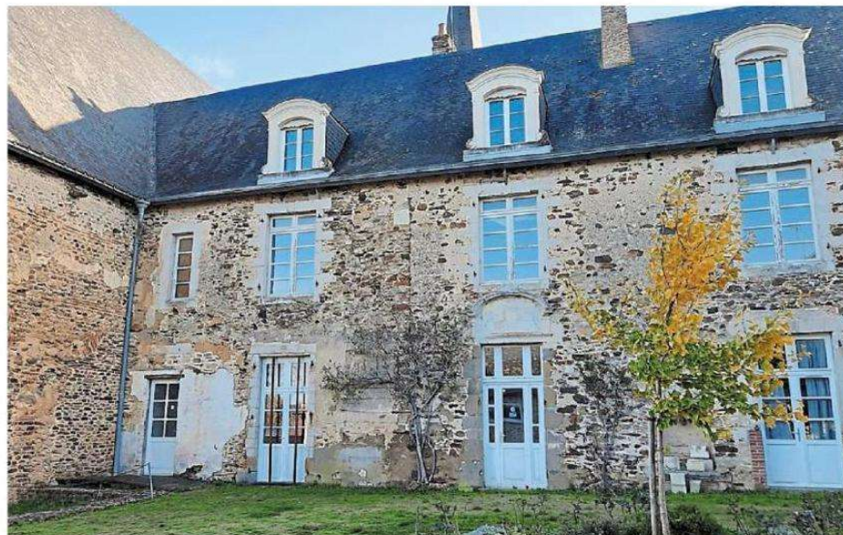
L'ancien presbytère, côté cour des Thermes gallo-romains. La charpente est liée à celle de l'église, au milieu de la façade, la marque de l'agrandissement datant de 1730 est visible, à droite, l'ancien puits.
