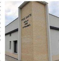
Le cabinet de santé d'Entrammes fait partie du pôle santé Meslay-Grez-Entrammes. | PHOTO : THOMAS BRÉGARDES / QUEST FRANCE
