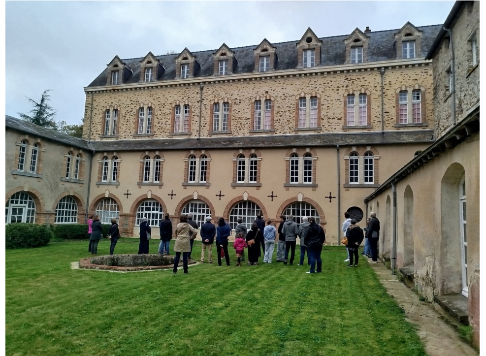
Bâtiment St. Bernard
