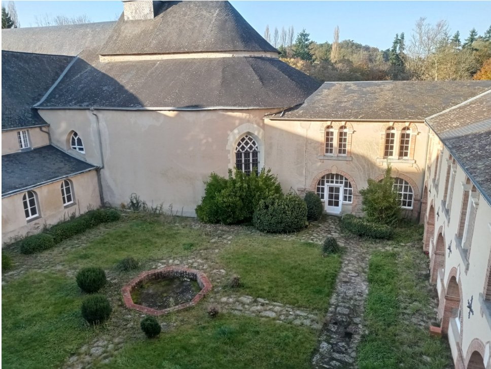
Le patio avant travaux.
